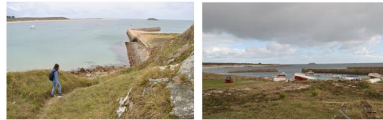
Figure 31 : Port Er Beg à Houat et Port la croix au Sud d'Hoedic, encore utilisés – E. Grousseau
