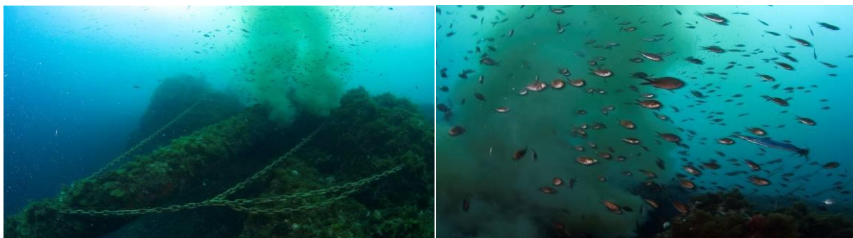
Figure 100 : Fuite observée vers -15 mètres en 2006 au niveau de l'émissaire de Saint Jean Cap Ferrat (source : Holon et Descamp, 2007).
